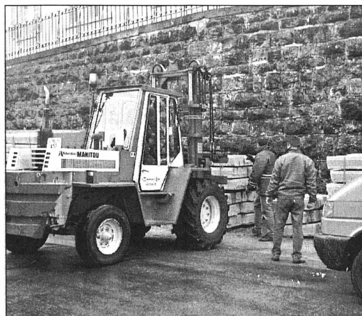
Les travaux commencent déjà; ici, avec un tracteur qui décharge des matériaux nécessaires à la préparation du chantier.
