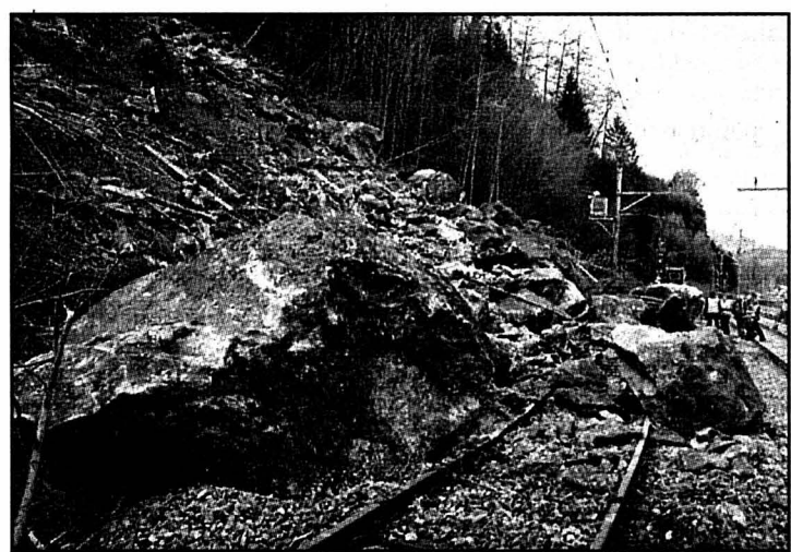
Boue et rochers sur la voie ferrée.
