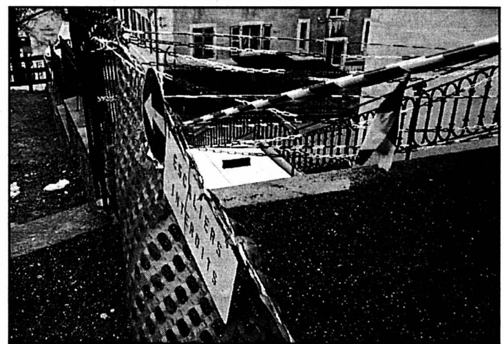
Réparation «d'urgence» pour les escaliers conduisant du Crêt-Perrelet à l'esplanade de la gare. Ils devraient, ultérieurement, faire l'objet d'une plus profonde réfection. photo Perrin
