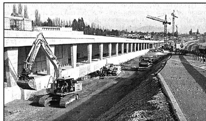
La tranchée qui contourne Bevaix plongera, entre Boudry et Cortailod, dans la galerie de Chanélaz.
