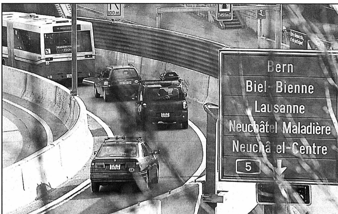
Le virage incriminé: sept accidents s'y sont produits depuis le début de l'année. Même s'il répond aux normes, les Ponts et chaussées vont tenter de le sécuriser. photo Leuenberger
