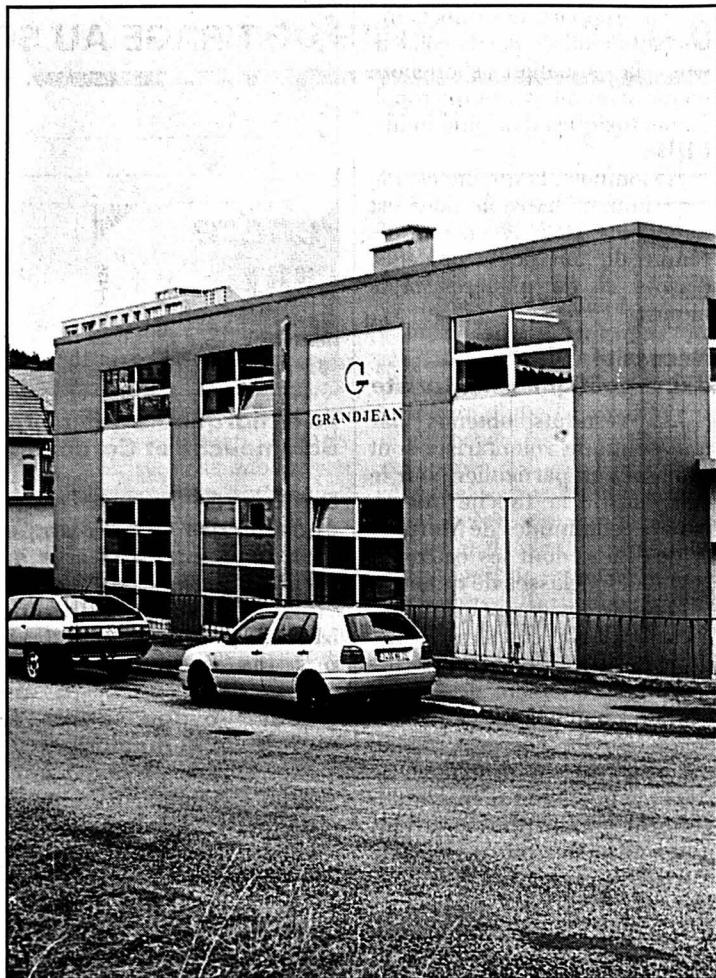
L'entreprise Grandjean SA, rue des Champs.
