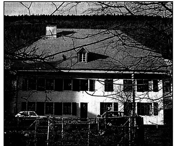
La vieille poste, un immeuble locatif mis sous protection à Cormoret. photo Egger
