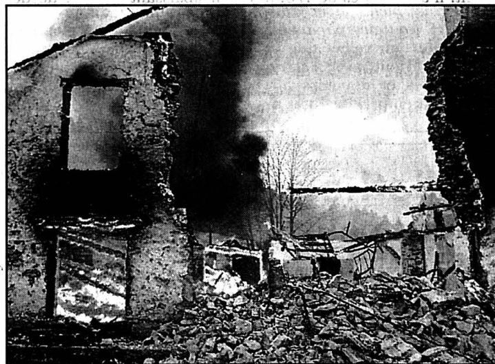
Destruction totale pour le corps de bâtiment qui a brûlé. photo Galley
