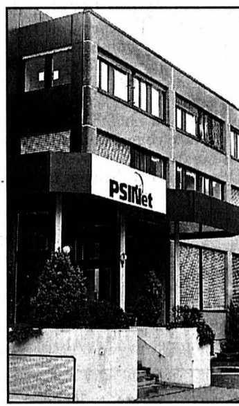
Le Centre technique européen à La Chaux-de-Fonds pourrait être compromis. photo Leuenberger
