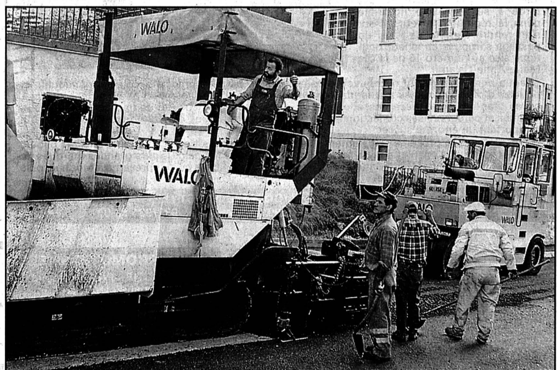
Très attendue, la phase du goudronnage de la chaussée. photo Leuenberger
