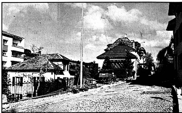
La pose de l'enrobé bitumeux va succéder à celle des couches de chaille et de groise, rue Alexis-Marie-Piaget. photo Nussbaum
