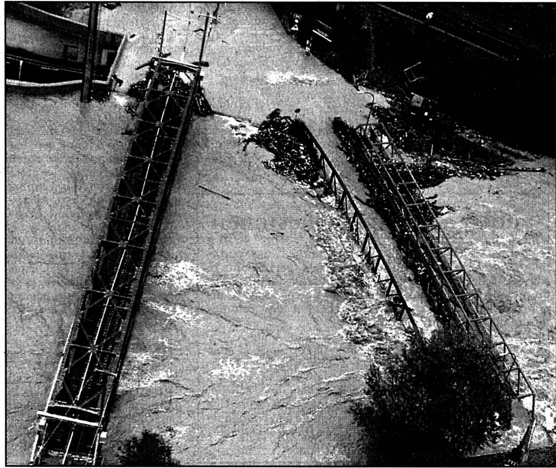
A Brigue, le Rhône en furie a inondé deux ponts.
