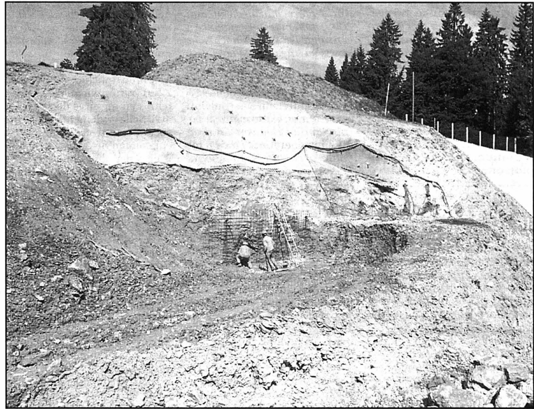
Pour consolider la paroi et permettre de construire en contrebas les stockeurs et digesteurs des boues de la station d'épuration, le talus sera recouvert d'une «peau» de béton sur 250 à 300 m 2 . photo Galley
