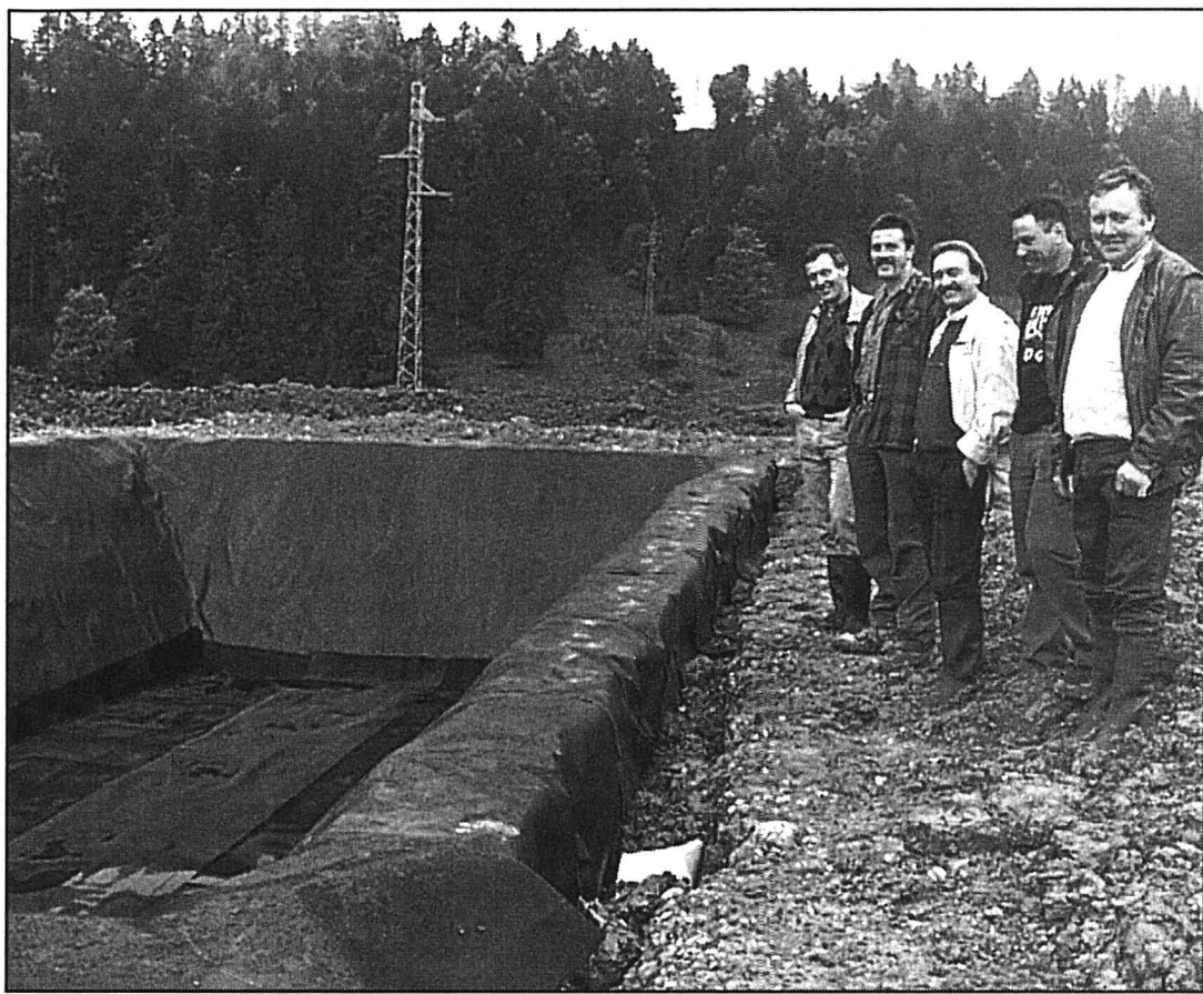
Au bord de la «piscine», Gilles Maire entouré des maîtres d'œuvre de l'ouvrage.
