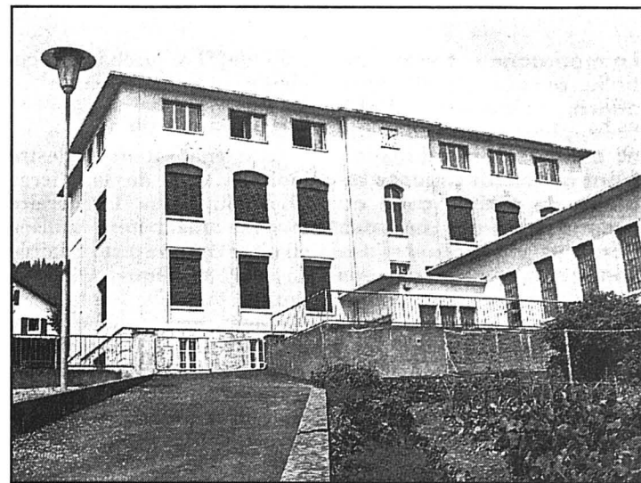
Dans le cadre du projet de programme de développement et d'investissements, il est fait mention d'une dépense brute de 2 millions pour la rénovation du collège et de la halle de gymnastique. photo a
