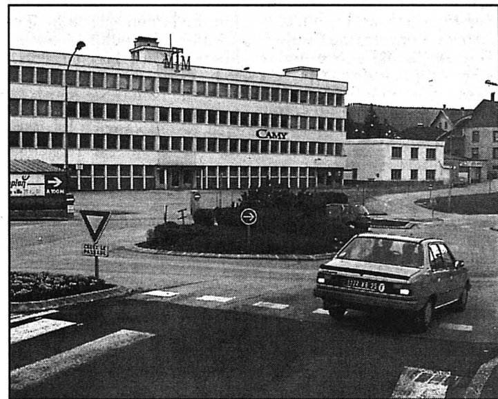
Le carrefour Cattin au programme des travaux 1997.
