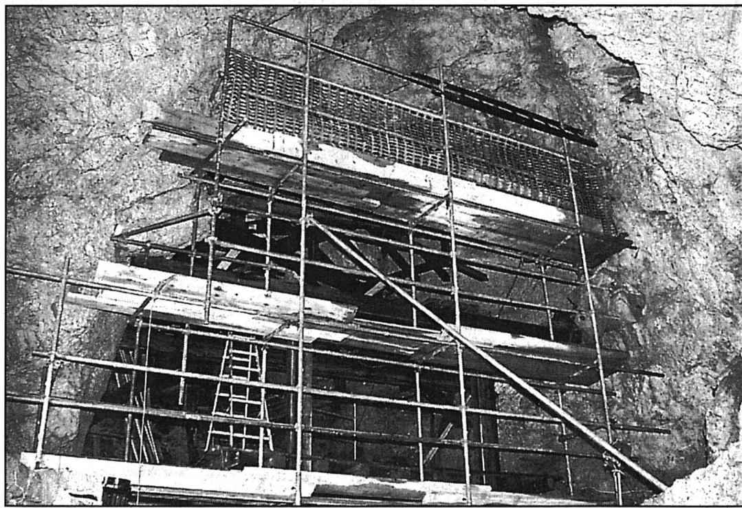
Echafaudages pour la reconstruction du moulin souterrain qui, lui aussi, sera plus beau qu'avant. photo Perrin
