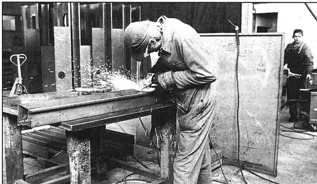
Depuis quelques mois, une petite dizaine d'ouvriers des Ateliers Vanoli & Fils SA, à Cornaux, travaillent quotidiennement à Fleurier où sont montés, entre autres, des bâtis de machines-outils. photo Treuthardt
