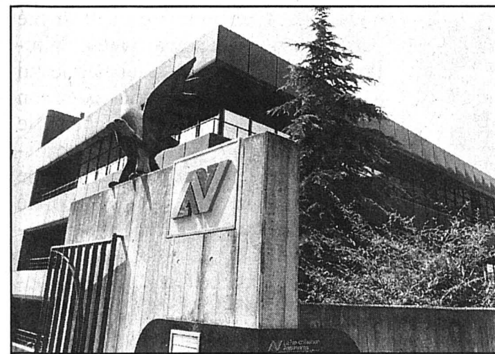
Les licenciements ont été prononcés par La Neuchâteloise Assurances. photo asla
