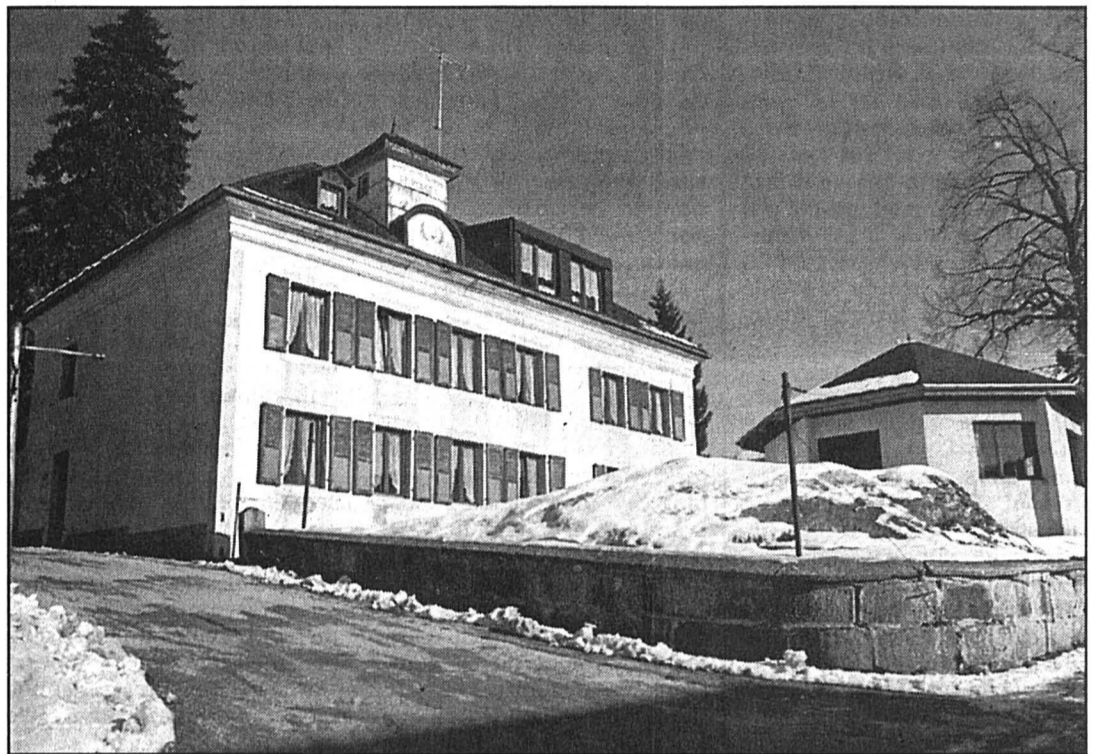
Ouvert en 1879, le home des Bayards, doyen du Val-de-Travers, est en butte à des problèmes financiers à même de mettre en péril sa pérennité. photo De Cristofano
