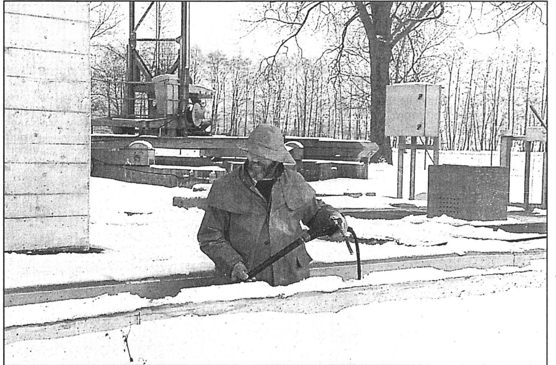
Les Services industriels de Couvet et de Fleurier ayant disparu, les stations d'épuration du Bas-Vallon (Boveresse sur notre photo) seront bichonnées par les employés de la société électrique du Val-de-Travers. photo De Cristofano
