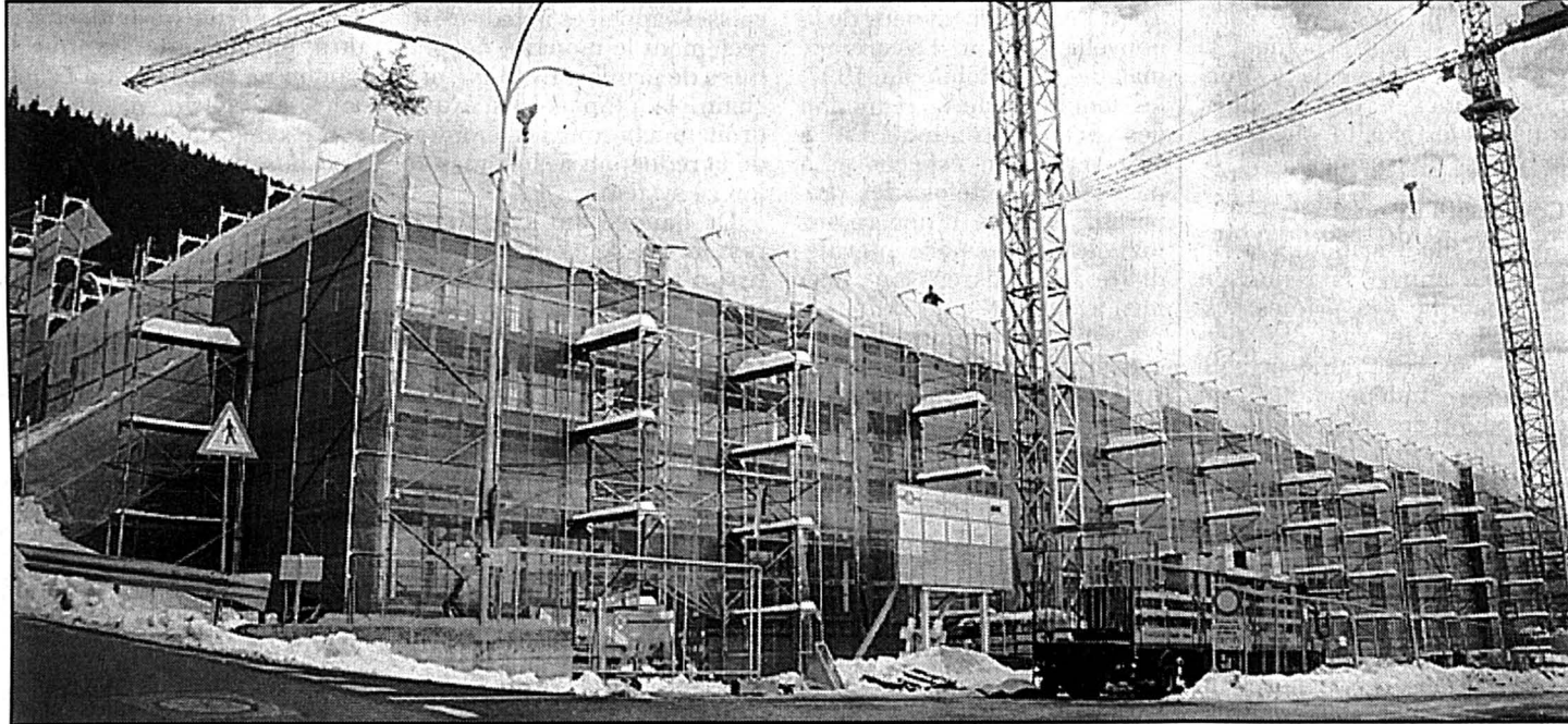
ETA a déjà débloqué 16 millions de francs pour la nouvelle usine.
