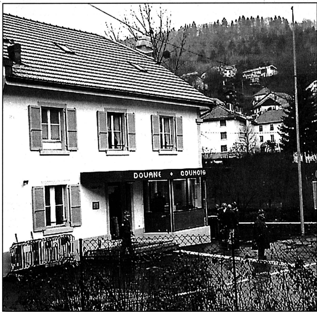
L'administration des douanes a investi 1,3 million dans la rénovation du poste de Goumois.
