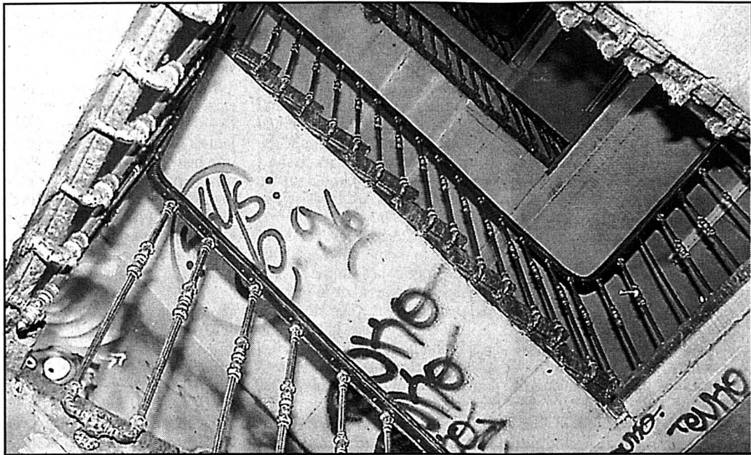
La cage d'escalier de l'ancienne Poste, tout de même une certaine allure.
