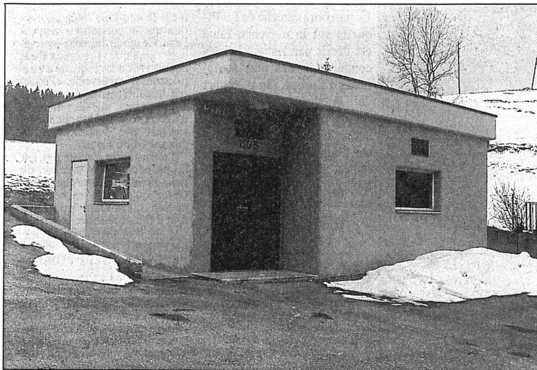
Station de pompage de La Brévine
