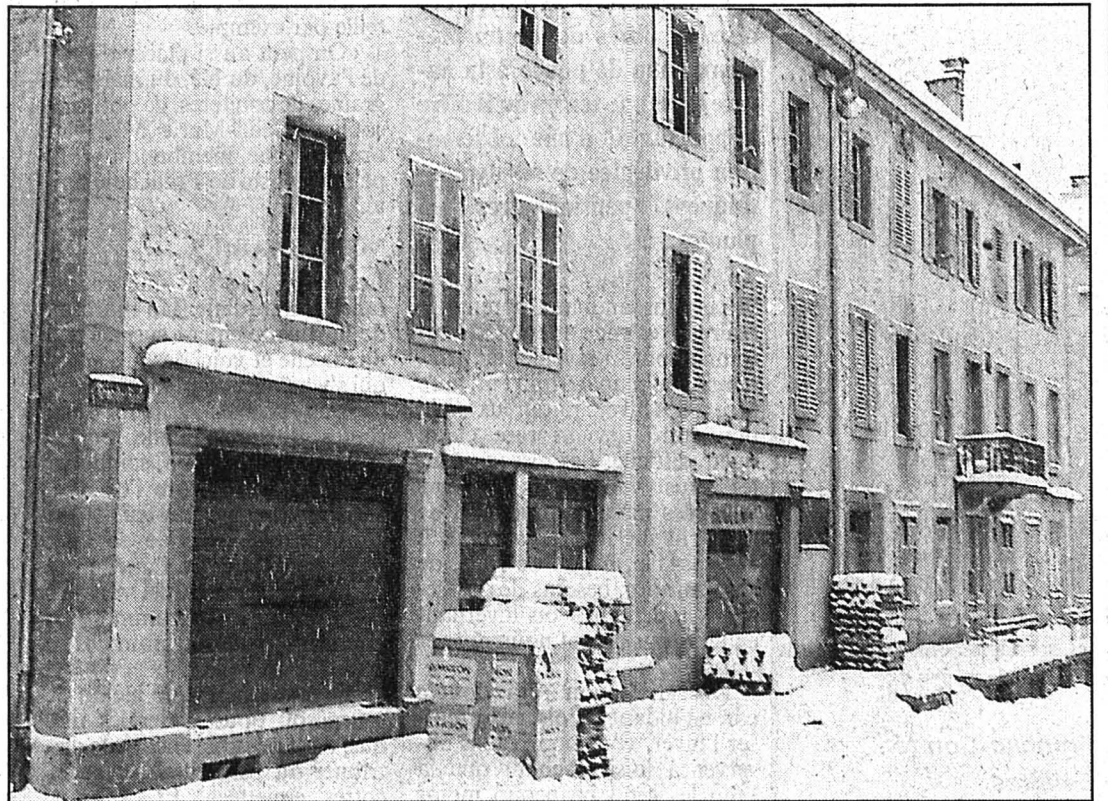
L'immeuble Grande-Rue 1 a été le théâtre d'un incendie début août 1994. Ses promoteurs et la commune, après des négociations difficiles, pourraient dégager une solution pour sa conservation. (Impar-Perrin)
