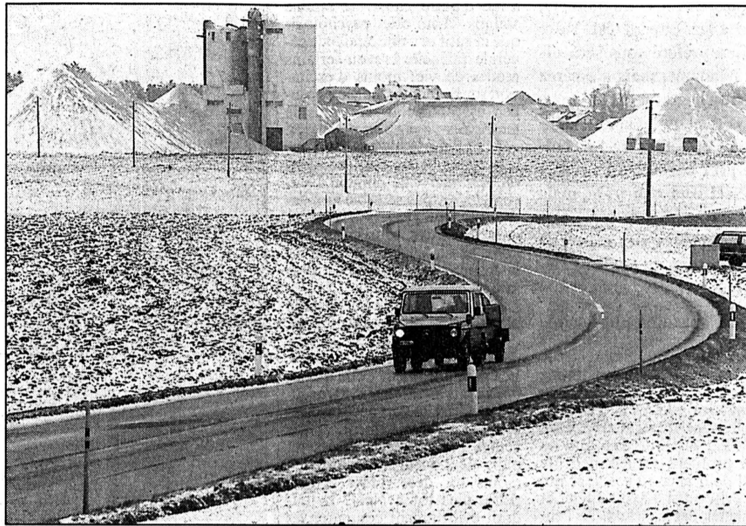
Route cantonale Coffrane-Montmollin
