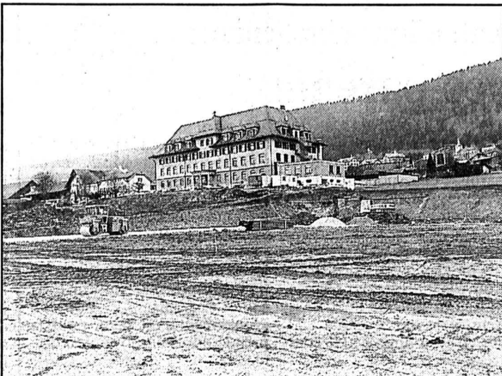
Gros travaux de fouilles
