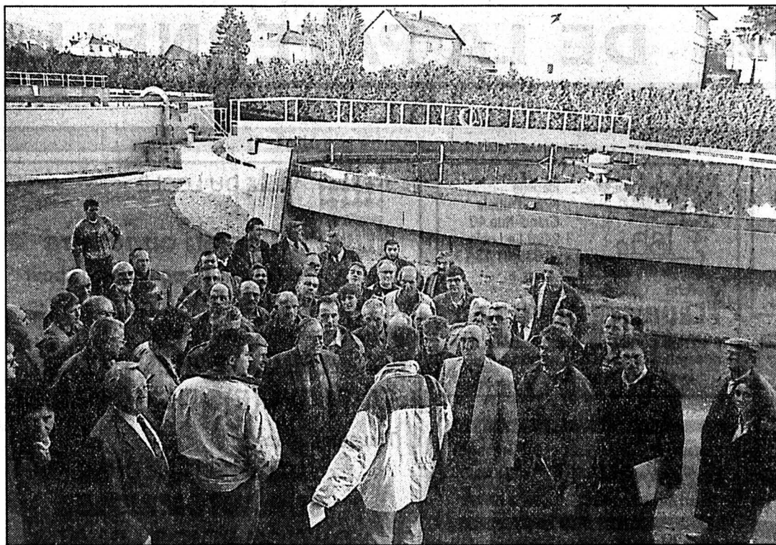
Station d'épuration de Morteau
