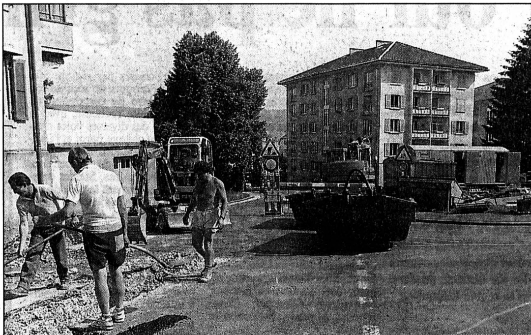
Chantier de la rue de Bel-Air
