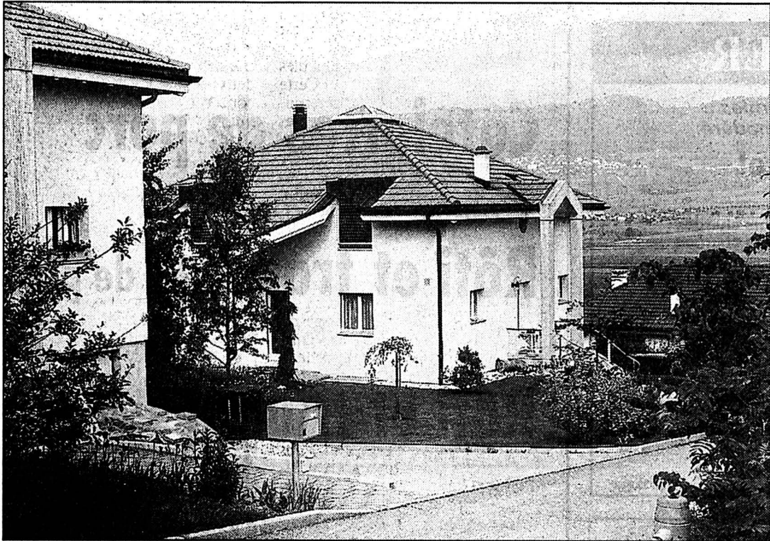
Lotissement à Saules Les architectes ont découvert des vestiges de villas romaines dans le sous-sol! (E)
