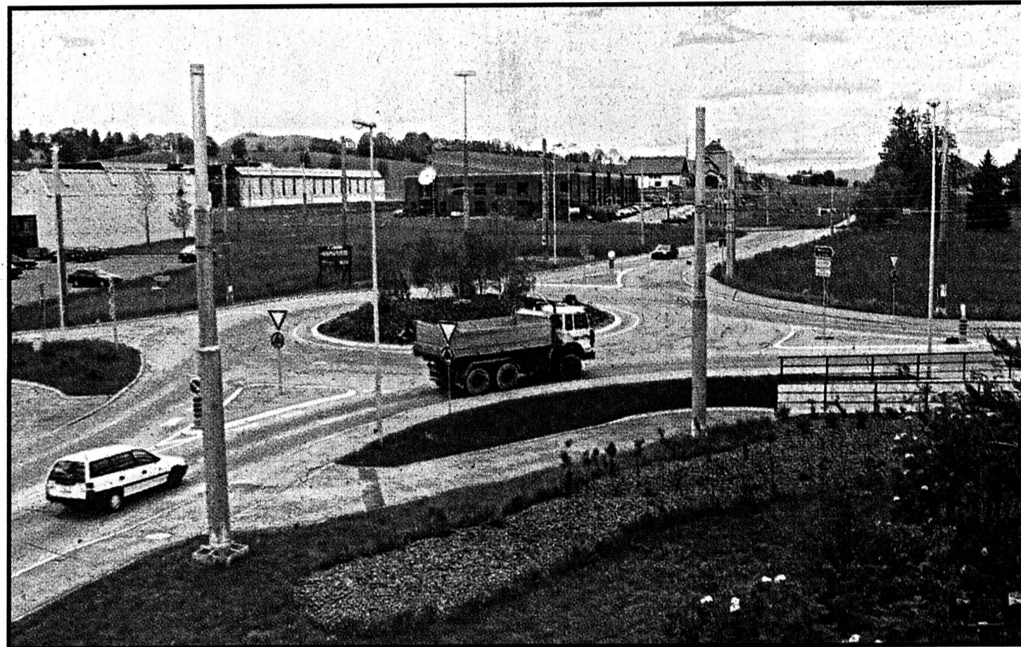
La Chaux-de-Fonds, giratoire de la Combe-à-l'Ours. C'est là qu'arrivera la nouvelle voie venant du Haut-du-Crêt.
