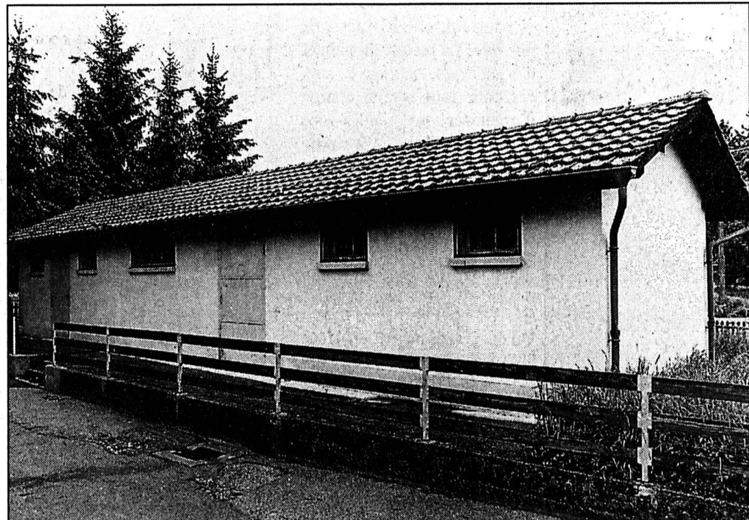
Station de pompage de Fontaines
