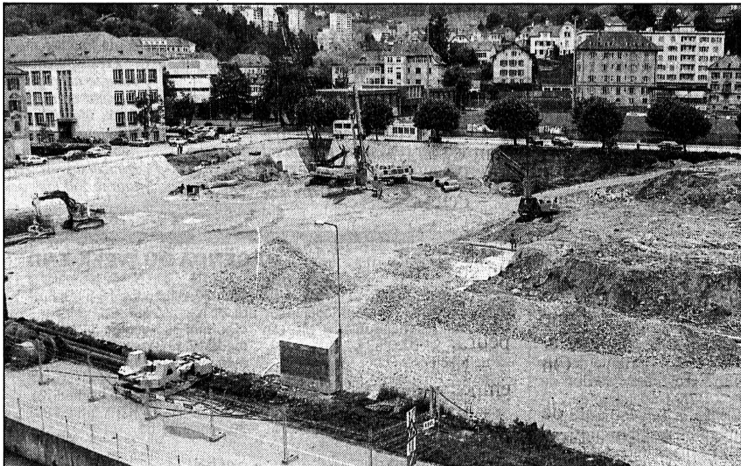
Etat actuel du chantier de la future Ecole technique
