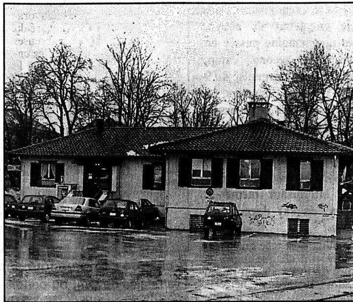
Le Chalet, près de la gare des marchandises
