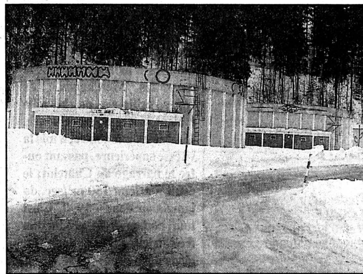
Vaillante station d'épuration.
