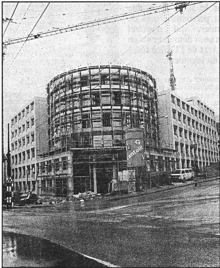
Nouvelle construction du CSEM
