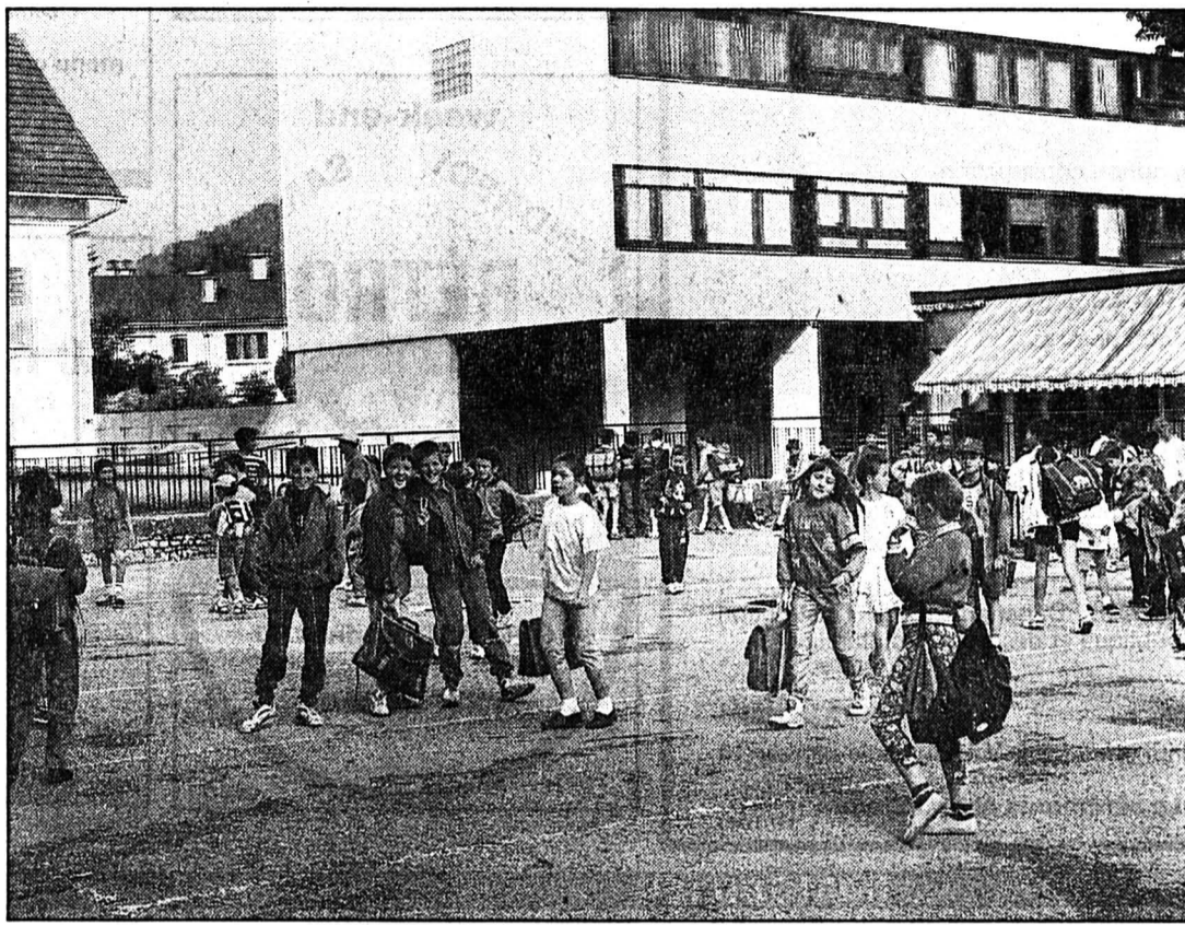
Ecole du Centre à Morteau Aucune fermeture à l'horizon.
