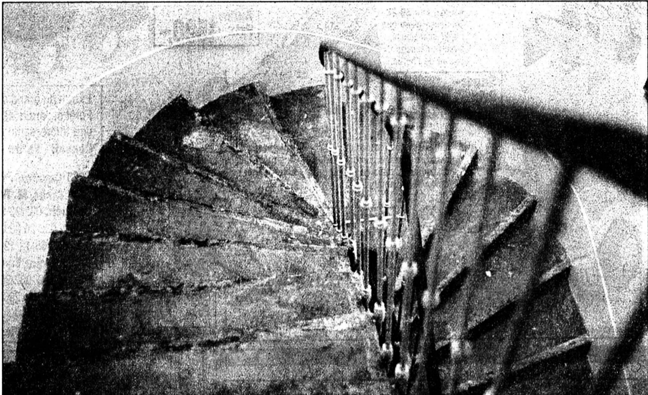
Pose d'un tapis sur un escalier. Les nez des marches peuvent être ébréchés. Un mortier leur rendra leur arête.
