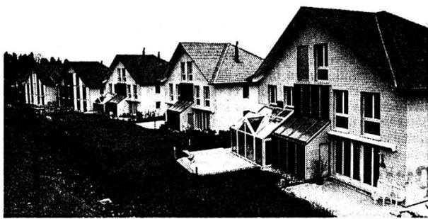
Les capteurs solaires fixés sur les façades sud des habitations à économie d'énergie de Wädenswil sont basés sur la nouvelle «technologie transparente d'isolation thermique». Pour les deux constructions à énergie thermique zéro (les deux premières maisons jumelles à gauche), les capteurs s'étendent sur toute la façade entre les deux grandes fenêtres.
