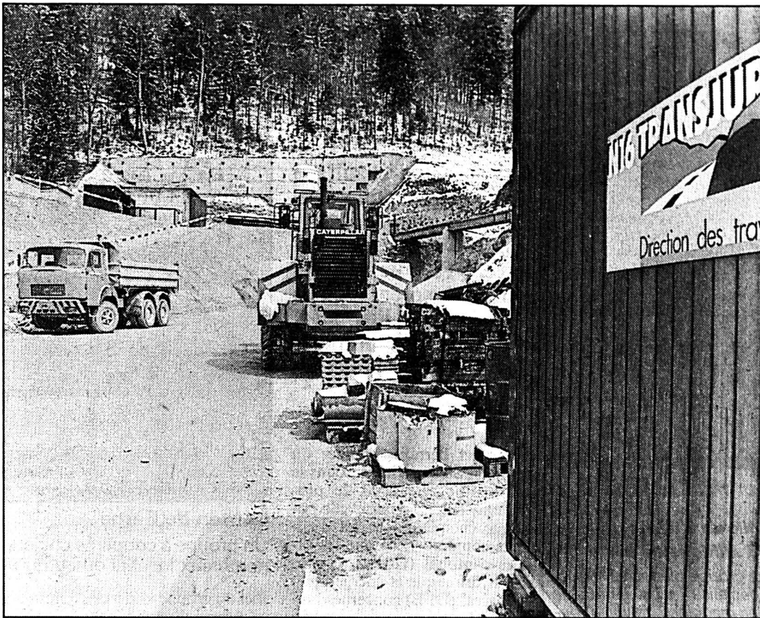
Chantier de la Transjurane à Sonceboz
