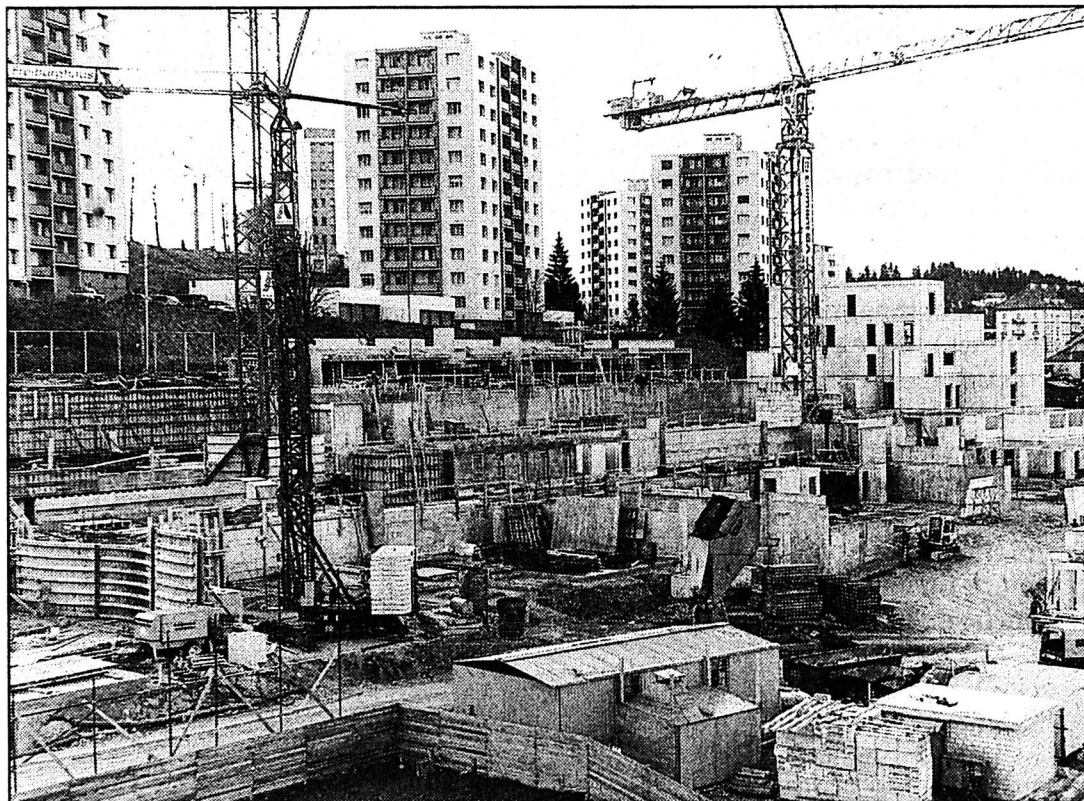
Le chantier Esplanade
