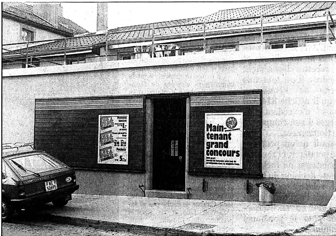
Le magasin Coop, rue du Crêt 96
