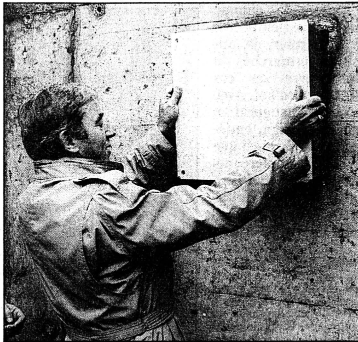
Pose de la première pierre
