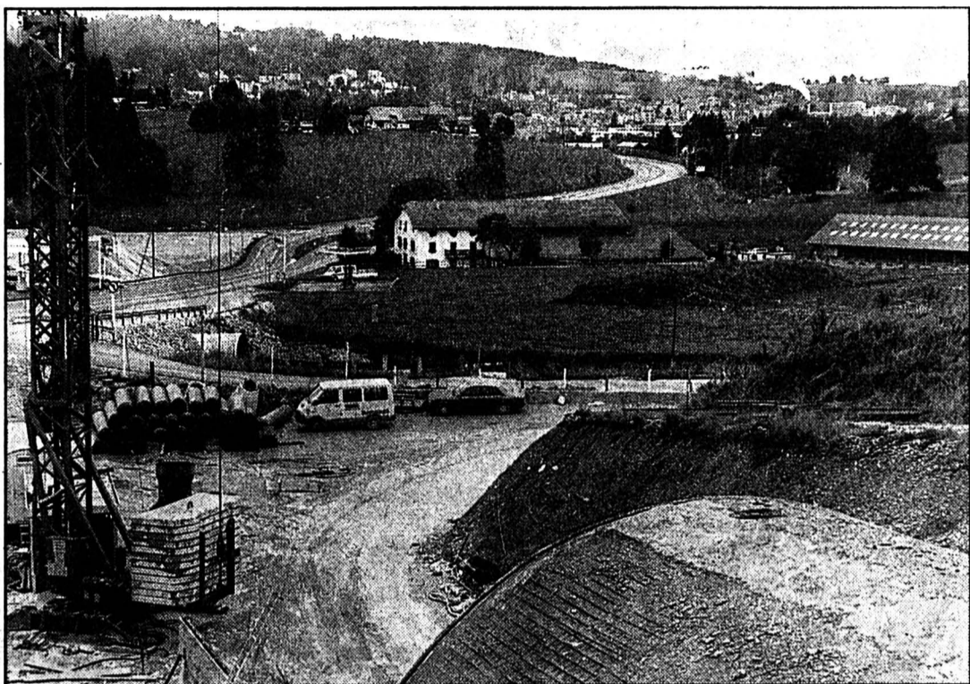
A la sortie du tunnel, le maillon manquant de la J20
