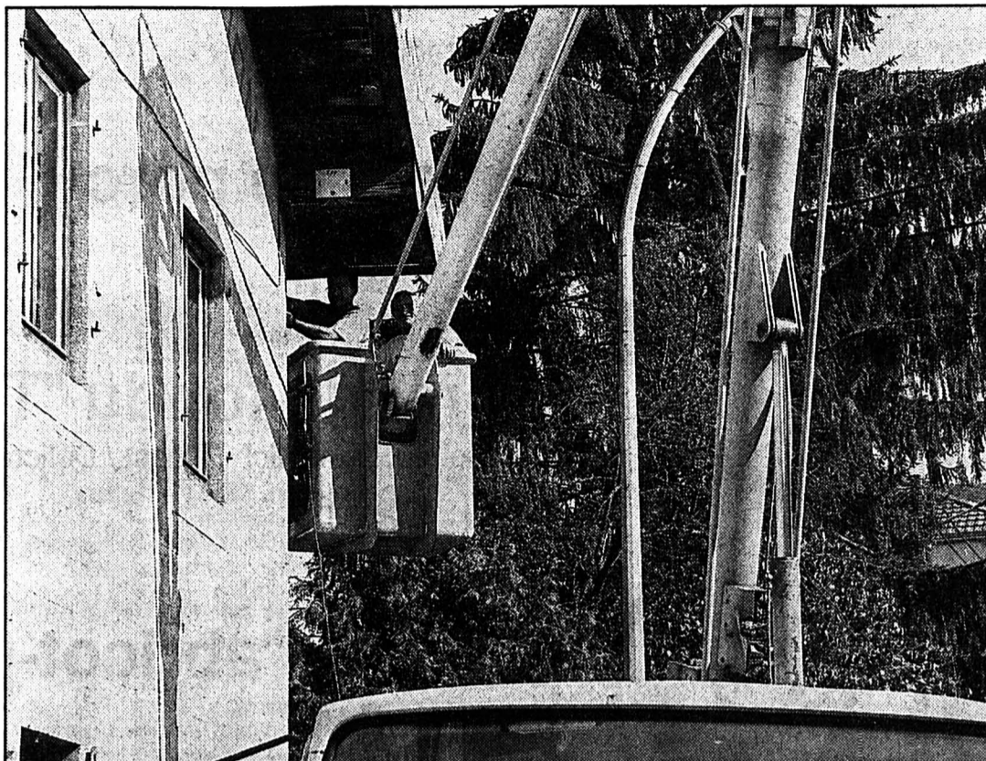
Travaux de câblage à Morteau Malheureusement trop de parties aériennes.
