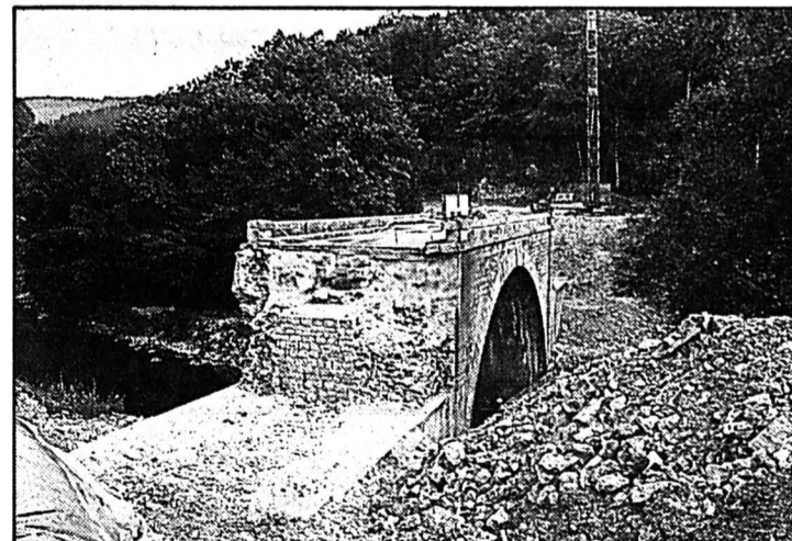
Le pont, en partie démoli L'axe Maïche-Belleherbe neutralisé.
