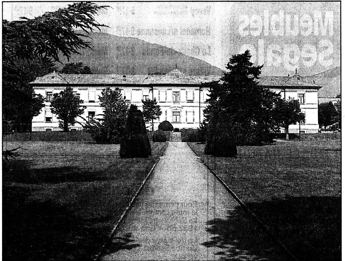
Hôpital cantonal de Perreux
