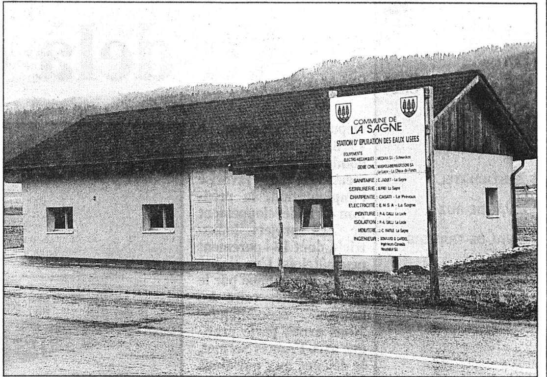
La station d'épuration de La Sagne
