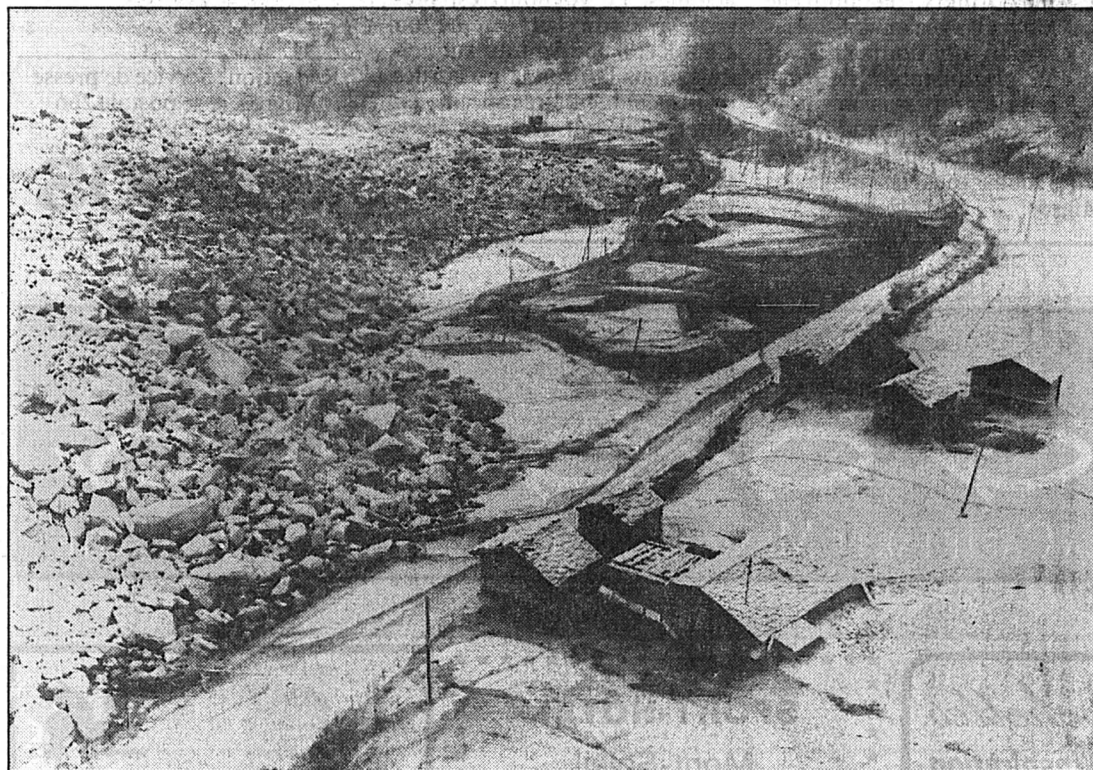
Près de huit millions de mètres cubes de rochers se sont à nouveau abattus entre Randa et Herbriggen (Haut-Valais) dans la nuit de jeudi à vendredi. Personne n'a été blessé, mais 24 bâtiments du hameau de Unter Laerch ont été ensevelis. (Keystone)
