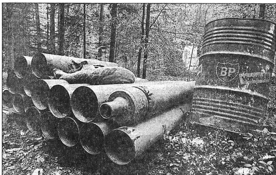
Installation de forages en vue d'analyser le sous-sol: les observations pourront se poursuivre dans les tubes laissés en attente durant près d'une année, voire d'avantage. (Comtesse)
