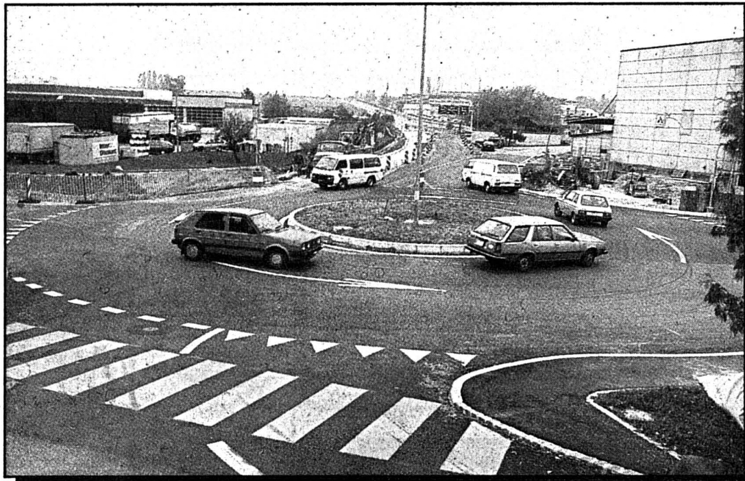
Le giratoire de Saint-Blaise. Une solution, en certains carrefours, susceptible d'améliorer la sécurité. (Comtesse)
