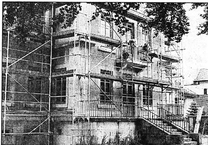
On installe les échafaudages. «Tout beau» avant l'hiver. (Impar-De Cristofano)
