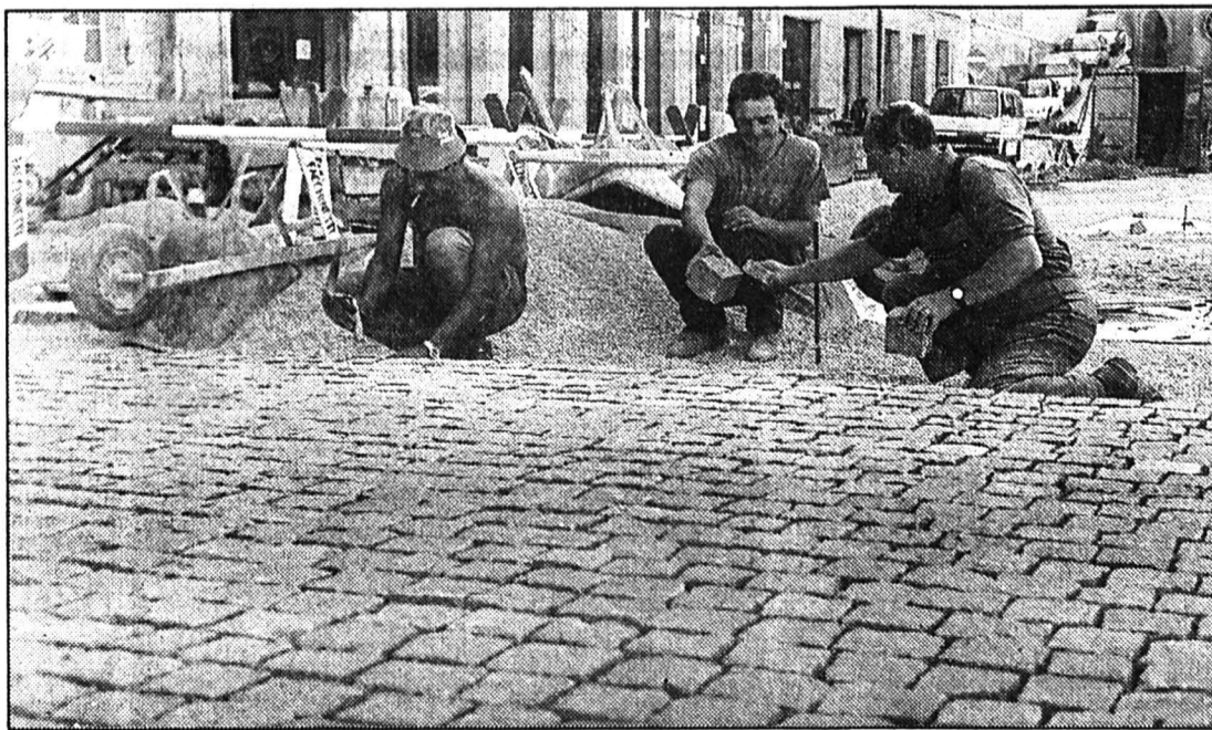
Sur du gravier, les cubes de grès du Portugal sont alignés.
